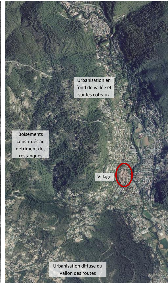
Figure 35 : Solliès-Toucas en 2014 : Une urbanisation dense en fond de vallée, des coteaux urbanisés et des extensions autour du hameau de Vallauray, des espaces agricoles résiduels et des reliefs boisés // Source : Geoportail, IGN
