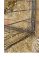
Nœud de chaînage - Continuité mécanique
