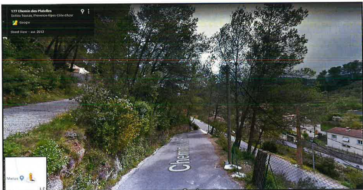
(Présence du réseau d'électricité)
